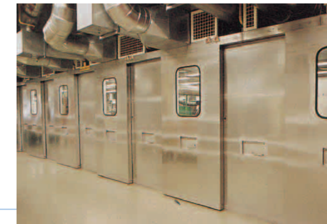
schalldämmende Schiebetüren für Aggregateprüfstände sound retardant sliding door for aggregate test stands
