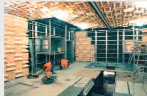
Aufbau eines kombinierten Klima- und semi-reflexionsarmen Messraumes. Installation of a combined climatic and hemi-anechoic test room.
