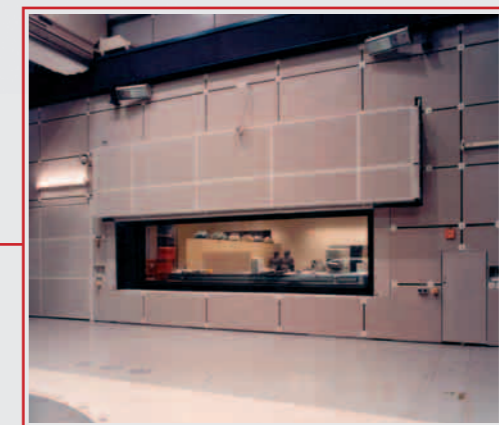
automatisch verschließbares hochschalldämmendes Beobachtungsfenster sound retardant observer window
