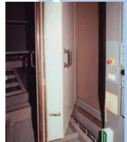
Schalldämmende Tür mit HF Abschirmung für Rundfunk- und Fernsehstudios, R_{WV} = 62\text{dB} Sound retardant door with HF shielding for radio and TV studios, R_{WV} = 62\text{dB}
